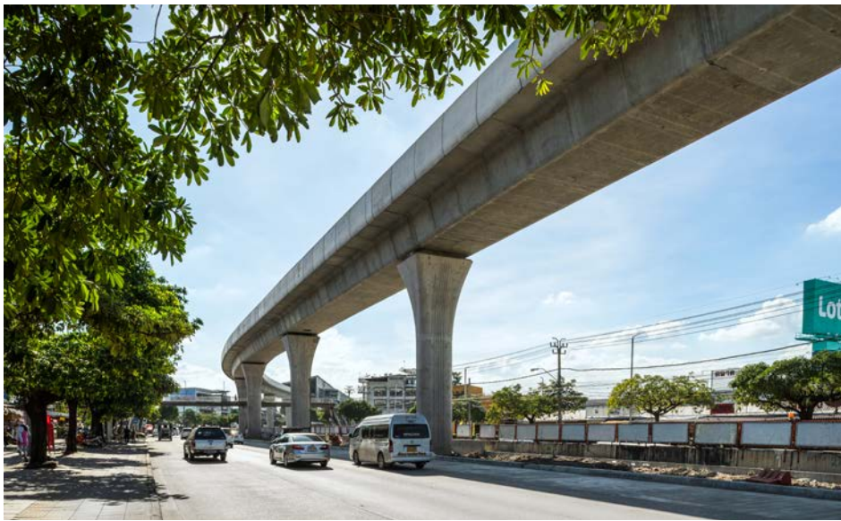
Die MRT Orange Line besteht aus unterirdischen und oberirdischen Schienensystemen. Der umfassende Service der Sika Experten vor Ort war für den Erfolg des Projekts von unschätzbarem Wert.
