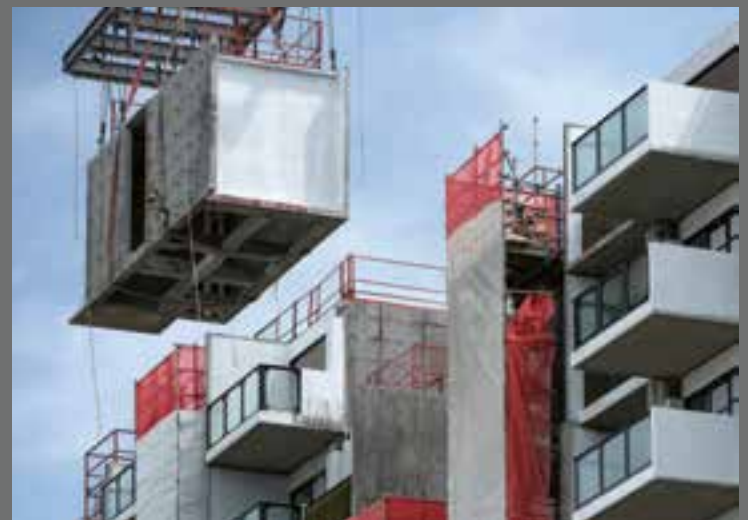
Avenue South Residence ist das weltweit höchste Gebäude, das im Modulbau gefertigt wird. Dieser Wolkenkratzer entsteht ebenfalls in Singapur. Bis 2022 erreichen die beiden Türme eine Höhe von 192 m und bieten Raum für mehr als 1'000 exklusive Wohnungen. Um die bis zu 30 Tonnen schweren Module in die richtige Position zu bringen, sind spezielle Baukräne im Einsatz.
