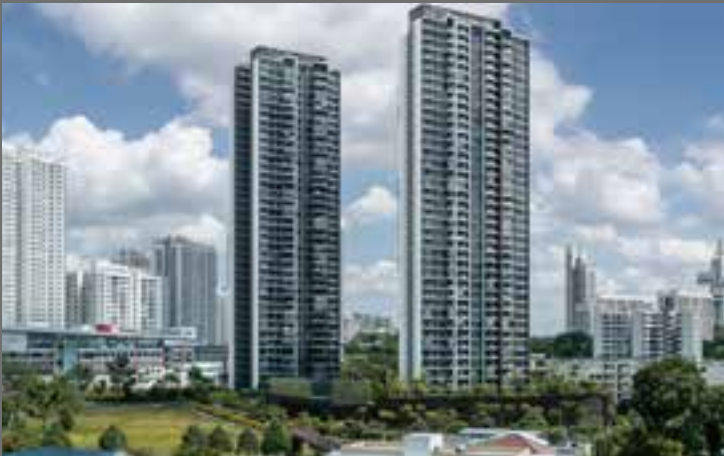
Die beiden Wohntürme des Clement Canopy in Singapur ragen 140 m in die Höhe. 1'900 Module, die für die 500 Wohnungen zusammengefügt wurden, bilden die tragende Struktur.
