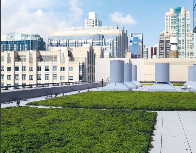
Mit der Übernahme von American Hydrotech wird Sika Marktführerin von Dachbegrünungen in Nordamerika. Die Übernahme passt perfekt zu Sikas Nachhaltigkeitsstrategie. Im Bild: Das begrünte Dach des Simpson Querrey Biomedical Research Center der Northwestern University in Chicago.
