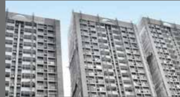
Sika unterstützt die Fassadensanierung von 19 Hochhausblöcken in Hongkong mit Abdichtungs- und Klebesystemen. In vielen Grossstädten herrscht bei Gebäuden und Infrastrukturen ein immenser Reparatur- und Instandsetzungsbedarf. Sanierungen von Gebäudehüllen sorgen für eine verbesserte Energieeffizienz, Langlebigkeit und Sicherheit.
