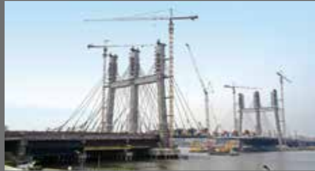
Beim Bau der Rod-Al-Farag-Brücke in Kairo kommt Sikagard®-550 W Elastic zum Einsatz, um eine Fläche von 600'000 m 2 Beton vor der Karbonatisierung zu schützen, sowie der fließfähige Feinbeton Sikacrete®-114. Nach Fertigstellung wird die Brücke sechs Fahrspuren in jede Richtung aufweisen und zwei Spuren für Busse und Metrolinien.
